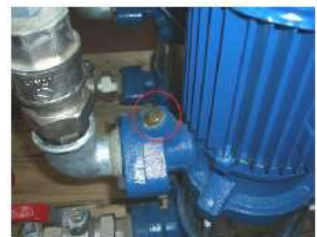
Obrázek 7: Montáž čidla na odvodu vzduchu výtlaku čerpadla
