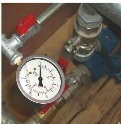
Obrázek 7: Nahrazený manometr
